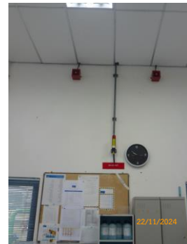
ภาพที่ 2.1-22 เครื่องตรวจจับก๊าซ CO
