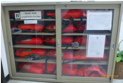
ภาพที่ 2.1-21 อุปกรณ์ป้องกันภัยจากก๊าซพิษ
